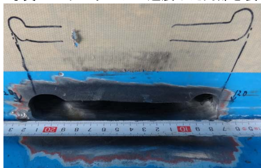
写真4 き裂除去全景
