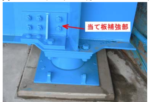
写真5 補強部材取り付け状況
