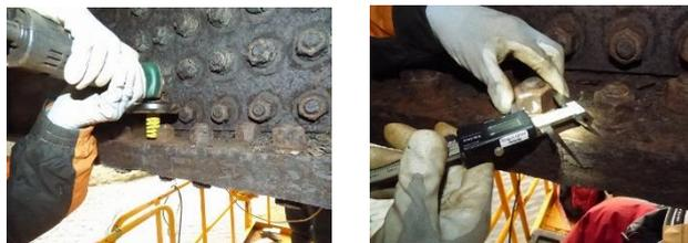
写真 2 添接部の高力ボルト調査状況
