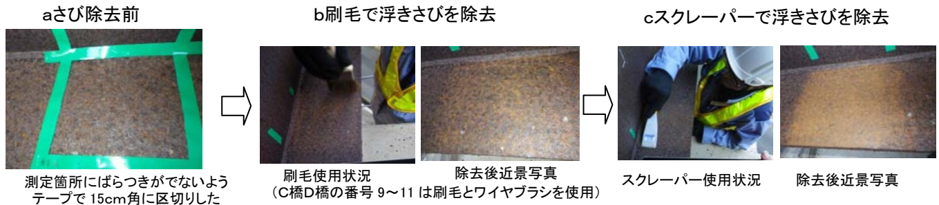
写真-1. さびの除去状況(D橋 番号 10)
