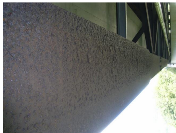
写真2 B橋 一番谷側の桁の下フランジ下面
