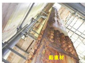
写真 2.3 鉛直材の腐食
