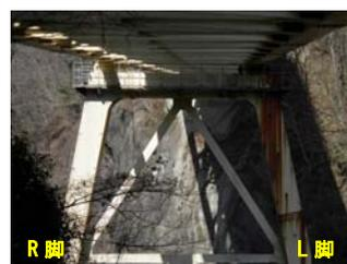
写真 2.7 排水管破損の L 側が腐食
