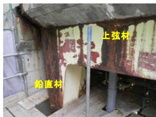
写真 2.2 上弦材の腐食
