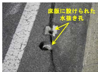
写真 2.1 床版の水抜き孔
