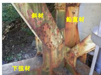
写真 2.4 下弦材の腐食
