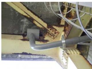
写真 2.5 水抜き孔下面
