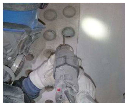
写真-1 実構造物での試験施工(試験施工 B)
