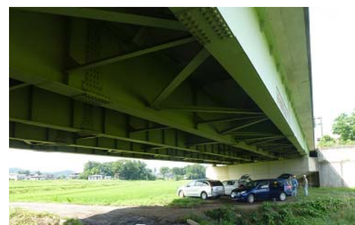
写真-1 対象橋梁外観
