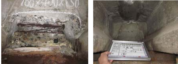
写真-1 横桁の損傷状況
