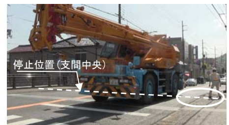
写真-1 静的載荷試験状況
