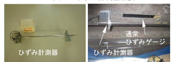
写真-2 計測器の設置状況
