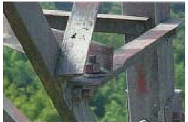
図-1 ボルト緩みの例
