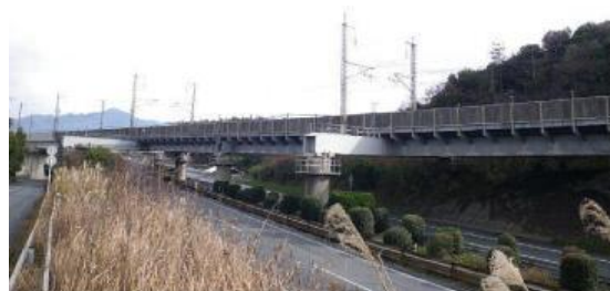
写真-1 橋りょう全景写真
