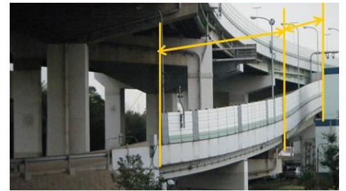
Fig.1 対象橋梁 外観
