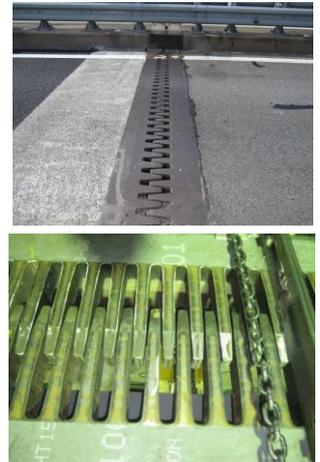
図1 フィンガージョイントの例
