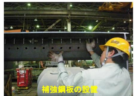
図-3 施工手順及び施工イメージ
