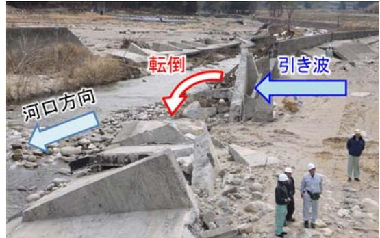
図-1 吉浜堤防の倒壊状況
