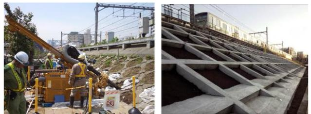
写真-1 盛土耐震補強工事の例
