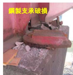
写真-1 被害状況(被災度A)
