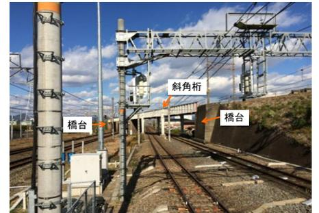
図1 鉄道の交差部における斜角桁
