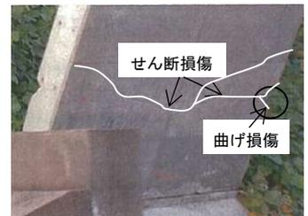
写真1 垂直材の損傷事例<sup>1)</sup>
