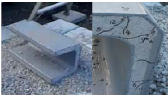
写真-4 錘の衝撃载荷（20回目）後の状況
