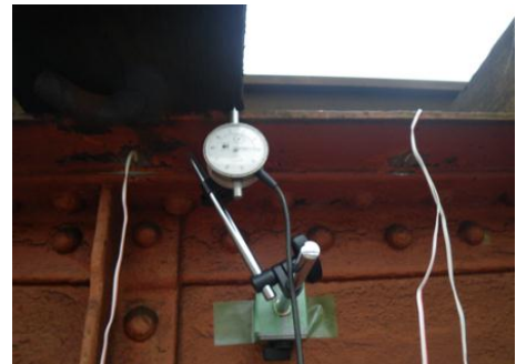
写真-3 変位計設置状況
