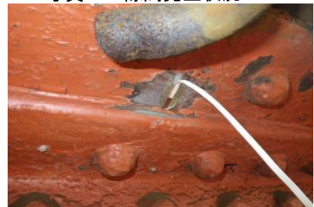
写真-2 ひずみゲージ貼付状況
