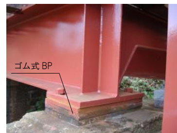
写真 1 ゴム式 BP 敷設のデッキガータ
