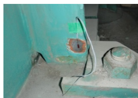
図-1 垂直補剛材計測状況
