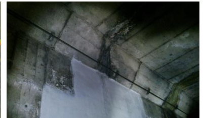
写真-2 右下トンネル上部
