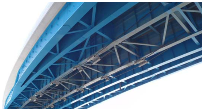
写真-1 B2橋外ケーブル補強の概要
