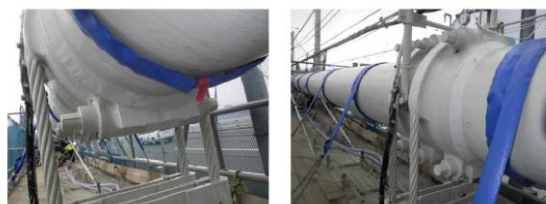
写真-2 改良工事後のケーブルバンド状態
