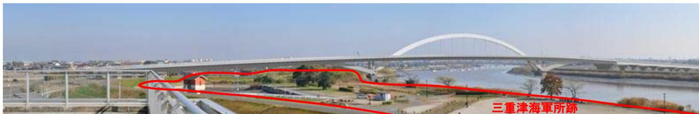
図3 1連アーチ+箱桁構造(採用案)
