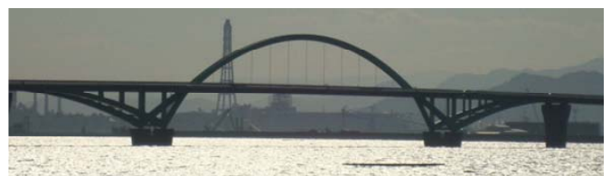
図4 新北九州連絡橋(鉛直材あり)
