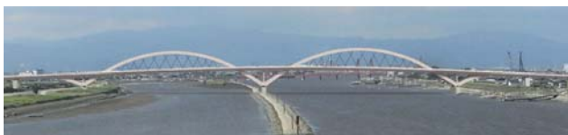
図1 デ・レイケ導流堤と筑後川橋梁
