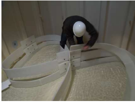
図-3 ダンパー施工の様子
