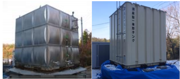
図-1 ステンレス製パネル式タンク 図-2 鋼板製一体形タンク
