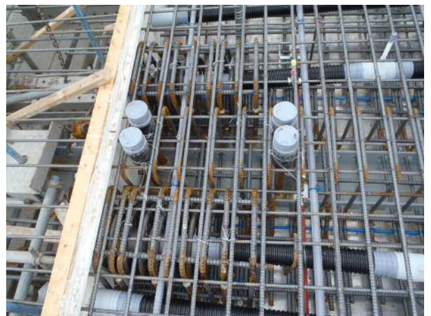
写真-4 実橋での配筋状況
