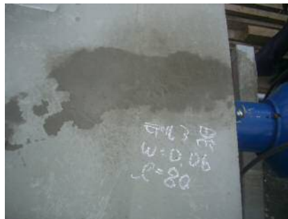
写真-2 緊張側状況
