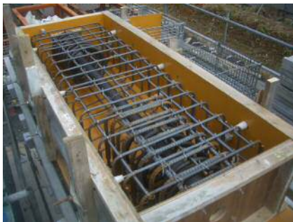
写真-1 実物大供試体配筋状況
