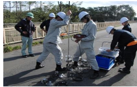
写真-2 小型 FWD 試験実施状況
