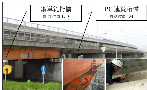
写真-1 計測橋梁
