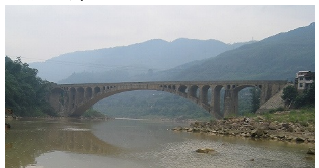
写真-1 支柱式石造アーチ橋
