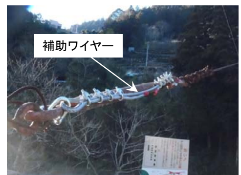
写真-5 同形部材の応急崩落予防対策
