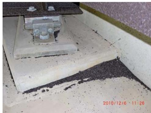
写真 1 剥落したさび片の堆積
