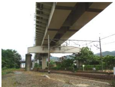
写真-1 受桁がある橋梁
