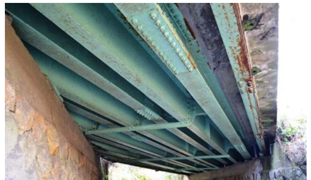
図-2 対象橋梁(桁下の状況)
