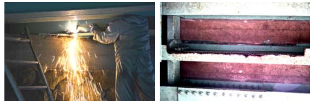
図-6 主桁ガス切断の様子
