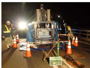
写真-2 振動試験状況
