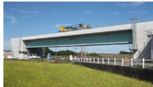
写真-1 成恒橋全景
