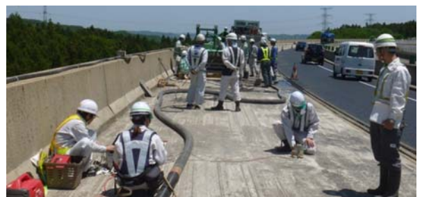
写真-1 測定状況 (K 橋)
