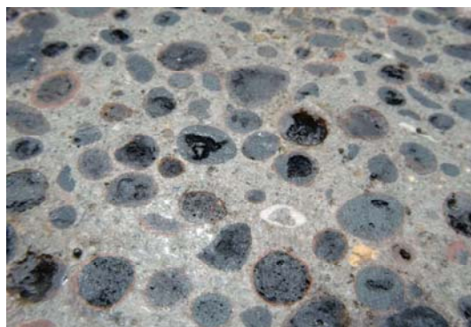
写真 2 プライマー材の標準量塗布後の状況
