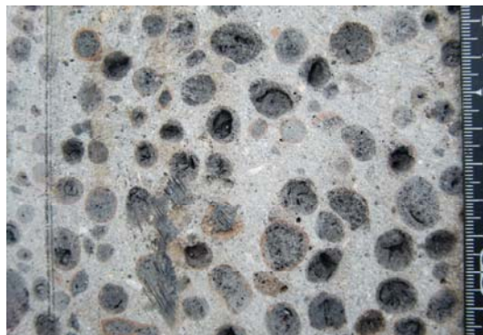
写真 1 軽量コンクリート床版上面の状況
