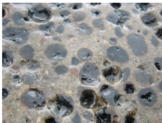
写真 3 プライマー材の増塗り後の状況
