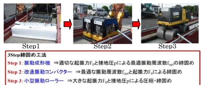
図3 「3Step 締固め工法」の概要
