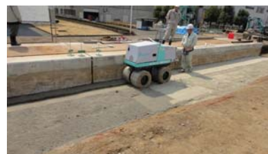
(c) 小型振動ローラによる転圧
