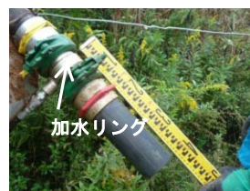
図-3 加水リングと 吹付ノズル
