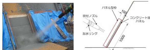
図-5 吹付け状況
