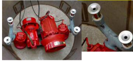
②マイクロバブル渦崩壊洗浄装置
