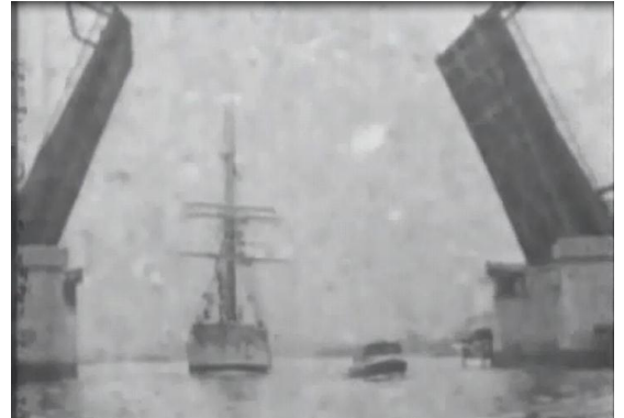
写真-1 映像委員会により発掘され東京都に複製が寄贈された「勝鬃橋」(土木学会土木文化映画委員会製作)映像のワンカット
