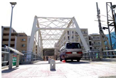
写真-3 開通後の霞橋
