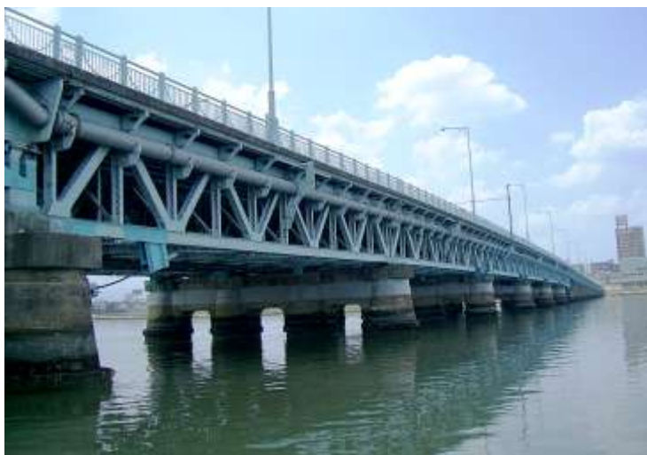
写真 1 対象橋梁外観
