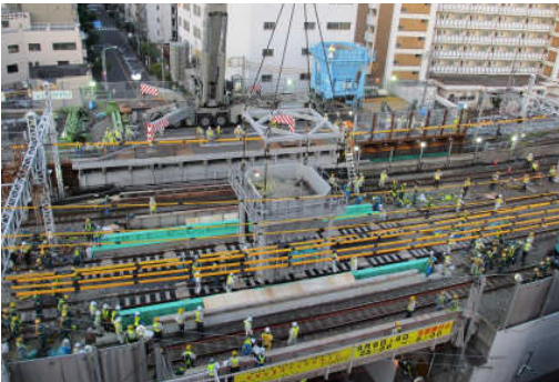
写真11 大型バラストホッパー使用状況
